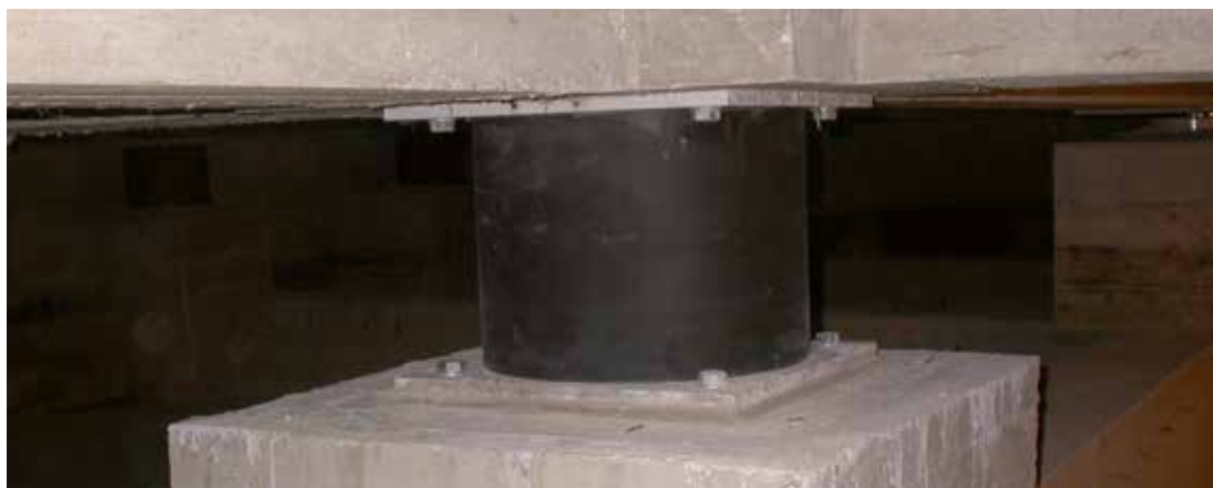
Figura 8. Posa in opera di isolatori (fonte: http://www.larampa.it/mondo/italia/laquila-sentenza-isolatori-sismici-nota-stampa-della-protezione-civile/ ) Isolatori a scorrimento: friction-pendulum system FPS)
