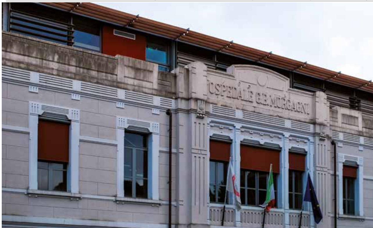
Foto 9: Dettaglio innesto fra l'antica facciata del 1912 e la sopraelevazione moderna con pensilina - © Alessandra Vignes
